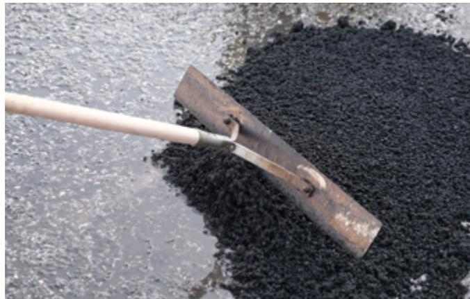
**1.** Stendere Pro Patch sulla superficie da ripristinare, distribuire uniformemente il prodotto **avendo cura di lasciare il materiale leggermente più alto rispetto alla zona circostante (il materiale, una volta compattato, avrà un calo di circa il 30% della altezza di stesa).**
