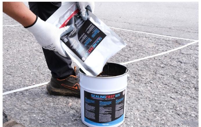
**2.** Versare il componente B nel contenitore del componente A, mescolando manualmente.
