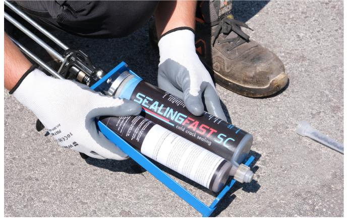
**2.** Inserire la cartuccia nella pistola erogatrice bicomponente e rimuovere il tappo. Avvitare il miscelatore monouso.
